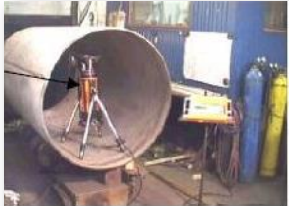
Inspeção radiográfica de soldas em tubos
