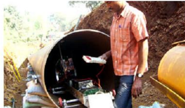
Crawler sendo testado antes de operar dentro da tubulação Foto extraída do website: http://www.sievert.in/Weprovide/crawler.html
